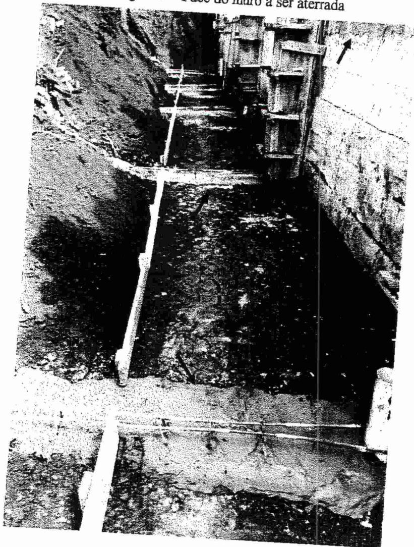
Figura 9 – Face do muro a ser aterrada
